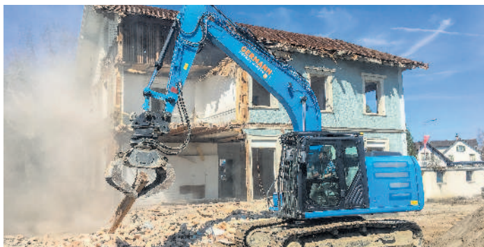
Vor einem Jahr begannen die Abbrucharbeiten am alten Kindergarten.
